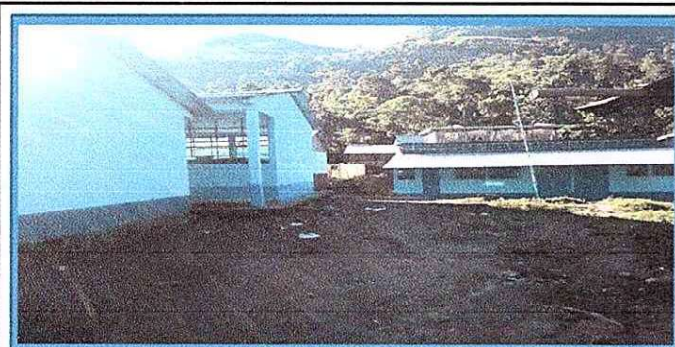
Los tres modulos finalizados.
